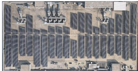
越南據點太陽能發電站建設
